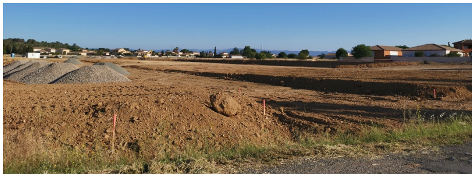
Figure 16. Travaux de viabilisation de la zone d'activités du Roudigou en 2021 Source : Urban Projects YE
