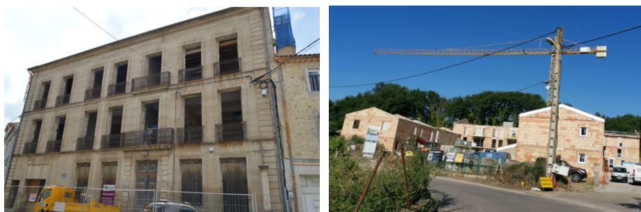
Figure 18. Logements sociaux en construction à Maraussan (à gauche, FDI Habitat ; à droite, Groupe Pierreval )
